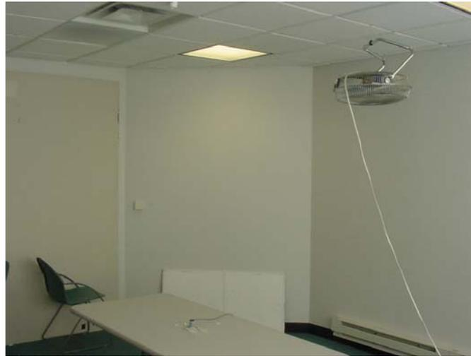
Figure 3.1 Destratification fan
